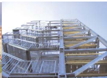
Stahlbau im Zusammenhang mit dem Umbau des alten Tower zur Aussichtsplattform
