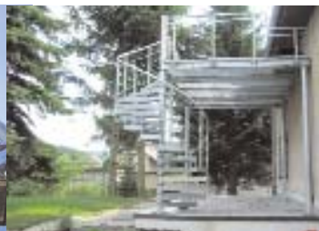
Balkon- u. Gartentreppe am Eigenheim
