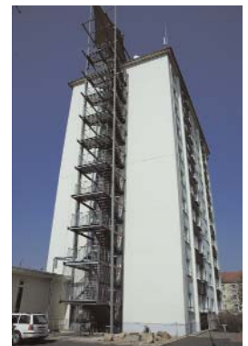
Klein-BHKW in einem Wohnhochhaus in Torgau
